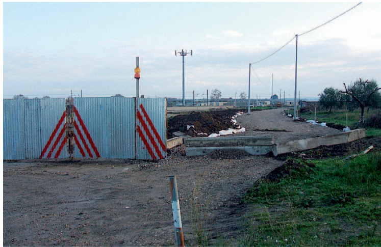
CANTIERE Via ai lavori sulla strada «Salinelle»
